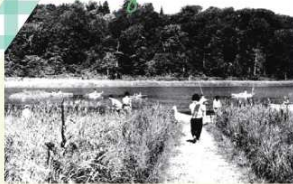
昭和31年ころの大沼自然探勝路。現在の展望デッキは、かつてボート乗り場の棧橋だった。水面にボートが浮かぶのが見える。(写真提供:八幡平レークイン)
