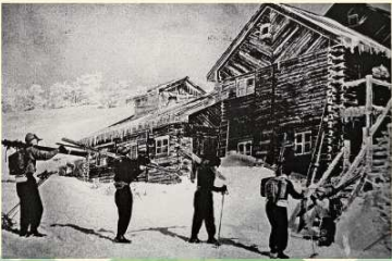
◀(左)昭和30年頃の絵ハガキの写真。ハガキには「素晴らしい樹氷は夢の園でありスキーヤーのパラダイス」と印刷されている。(右) 県営ヒュッテ「蓬莱荘」。昭和26年完成。道路開通のため取り壊しとなるまで、登山者に親しまれた。(写真提供: 十和田八幡平国立公園管理事務所)
